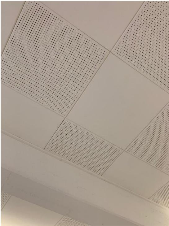
**Nur die Hälfte der Decke ist mit Schallschutzelementen bestückt.**
